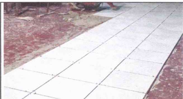
Foto 6: se observa el avance de la instacion de piso ceramico en modulo No. 1
