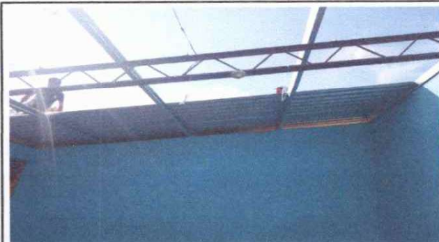
Foto 2: Se observa el proceso de la sustitucion de costaneras. Modulo No. 1
