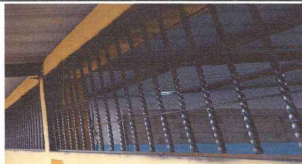
Foto 4: Se observa el avance de mantenimiento de balcones modulo No. 1,2 y3.
