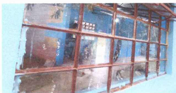
Foto 3: Se observa el avance de sustitucion de vidrios. En modulo No.2 y 3
